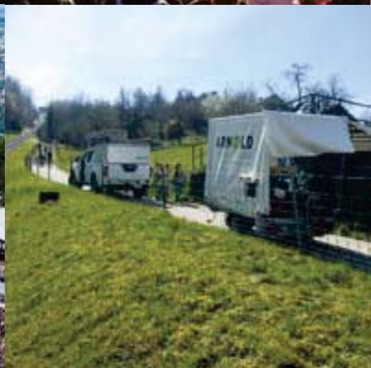
Installation des Kabels entlang der Gurtenbahn-Trasse
