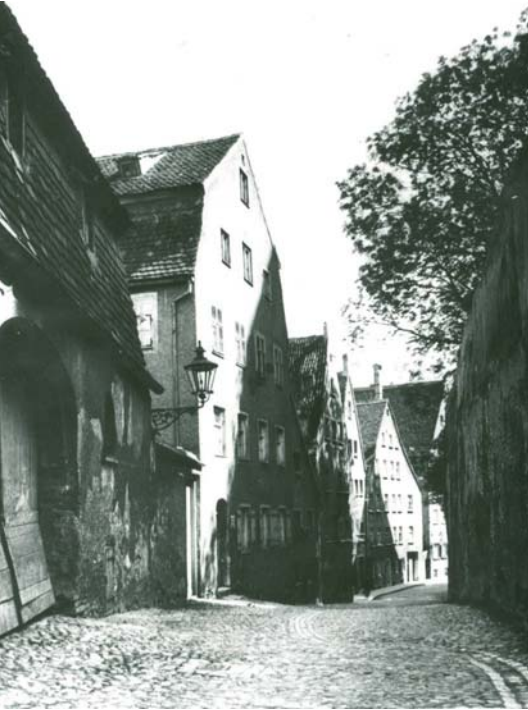
◀ Baufällig, dunkel und holperig: eine Seitengasse der Kirchgasse um 1960 [Foto: Archiv Ulrichsviertelverein e.V.]
